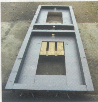
◀ Ajoneuvovaakan asennusta helpottaa valmis kehikko, joka kiinnitetään ennen valua perustukseen. Vaaka kiinnitetään kehikkoon.
